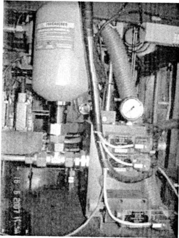
VÁLVULA DE PROTEÇÃO HIDRÁULICA
