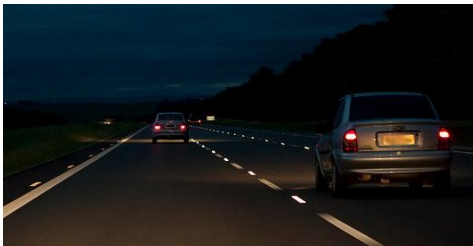
Figura 02 – Veículo em rodovia sem iluminação
