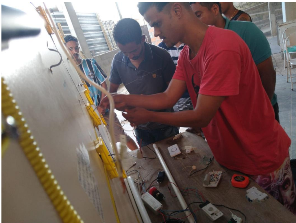
Pequenos reparos- Ribeirão das Neves
